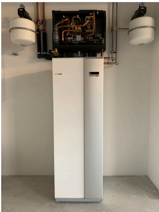
Figuur 28: Foto van de NIBE warmtepomp, met daarboven een afleverset die qua afmetingen vergelijkbaar is met de afleverset die voor het ZONNET concept wordt ontwikkeld.
